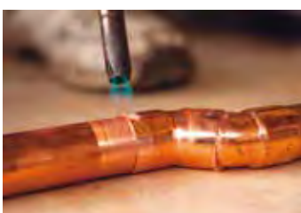
Auch das Löten von Kupferrohren gehört zu den Aufgaben.
