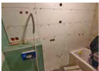
Keile zwischen den Fliesen sorgen für regelmäßige Abstände
